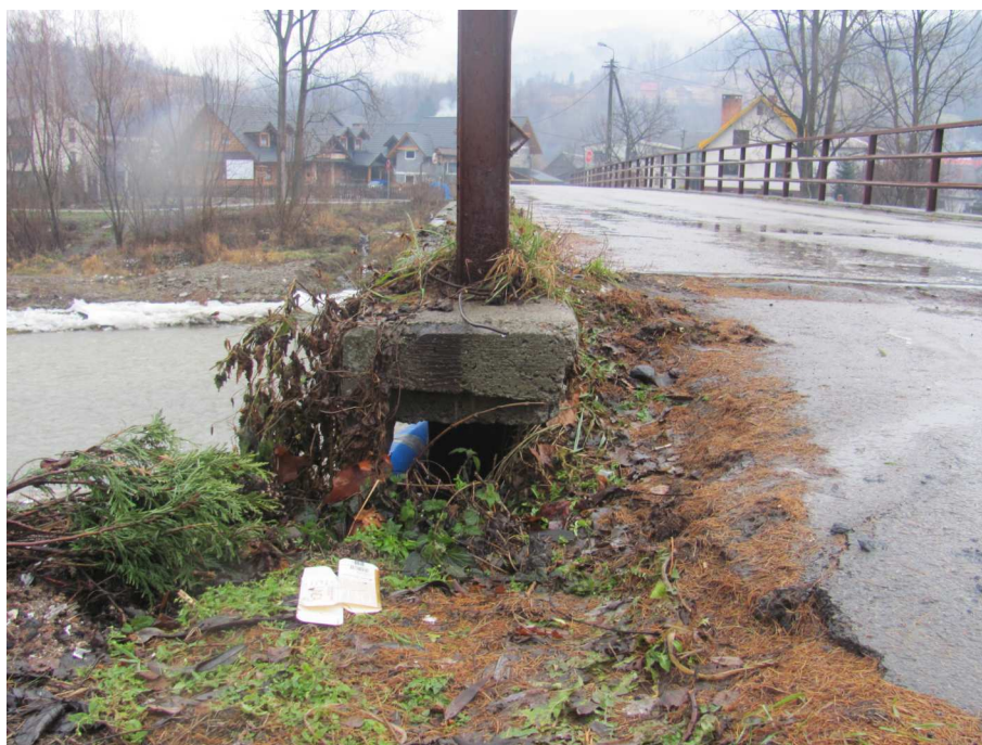
Fot. 8 Ubytki nasypu drogowego, ubytki podbudowy
