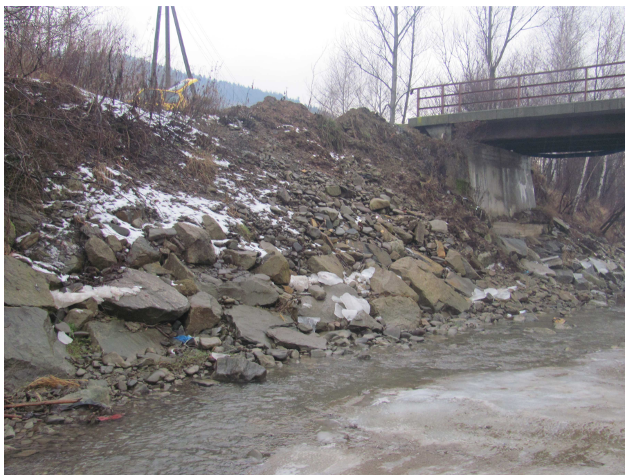
Fot. 3 Podmyty lewy przyczółek, rozmyty lewy brzeg i osunięte stożki nasypu
