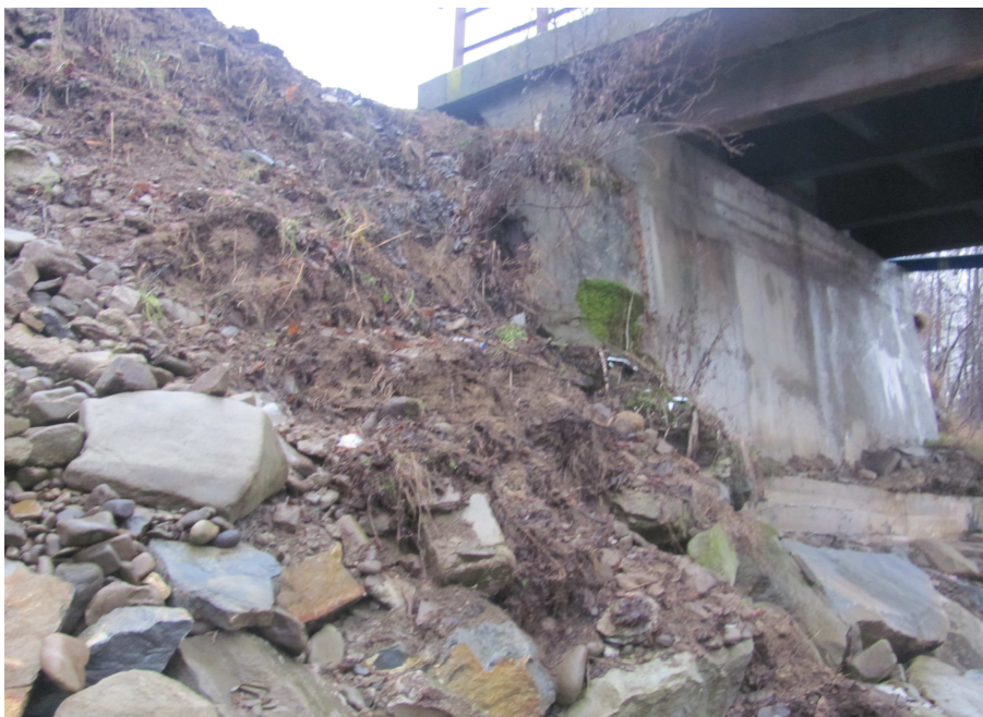
Fot. 4 Osunięty lewy stożek od str. górnej wody, odsłonięte skrzydełko
