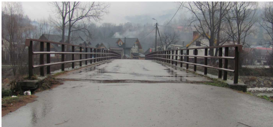
Fot. 7 Deformacje nawierzchni na dojeździe, pionowy uskok za ścianką zapleczną
